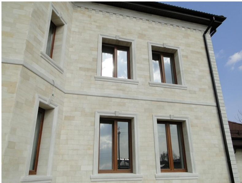
Дом, фасад которого выполнен из натурального песчаника.
