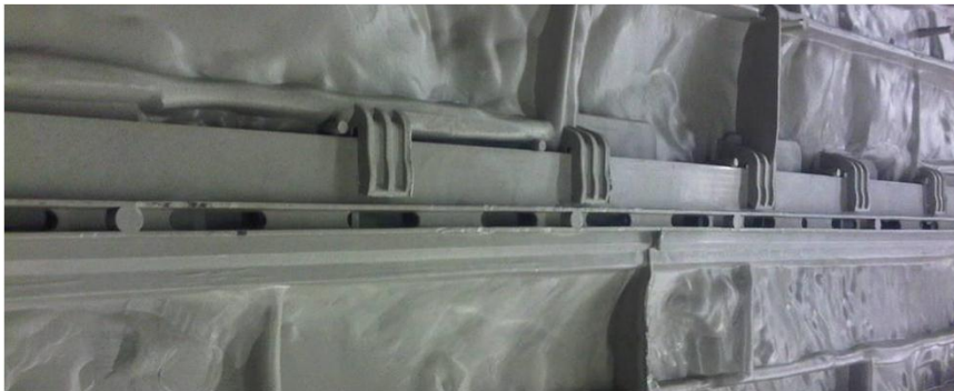
замковая часть панели после внесения изменений
