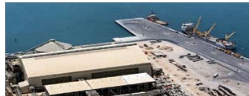
Завод по производству серы. Катар. Летняя температура +50°C. Агрессивная среда внутри и снаружи здания.
